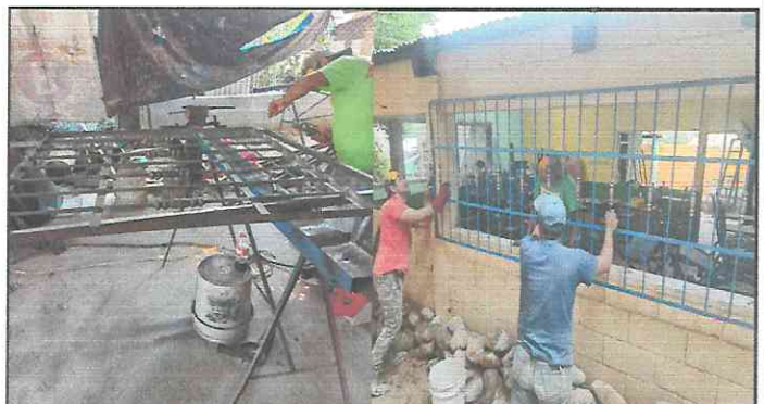
FOTO 4: FABRICACIÓN E INSTALACIÓN DE NUEVOS BALCONES.
