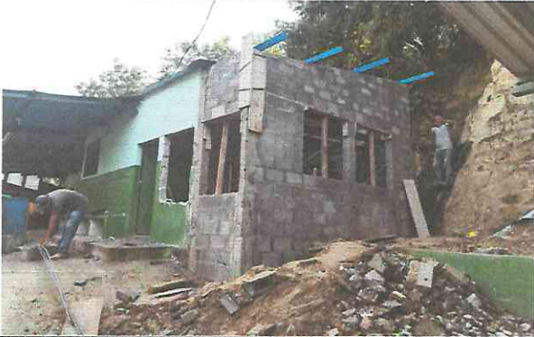
FOTO 1: SE REALIZA EL LEVANTADO DE PAREDES EN LA COCINA Y LA AMPLIACIÓN DE ESTRUCTURA Y TECHO
