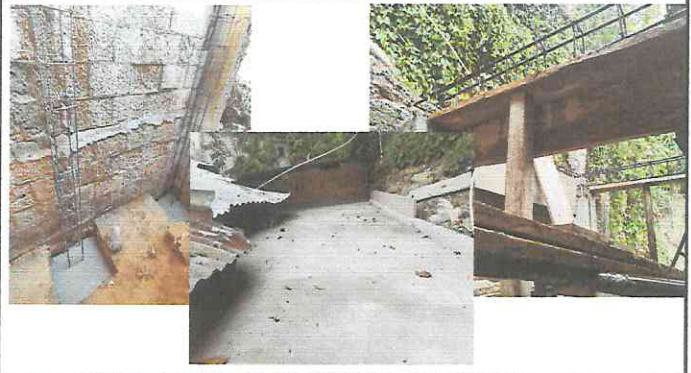
FOTO 2: FUNDICIÓN DE COLUMNAS, ARMADO Y FUNDICIÓN DE VIGAS Y FUNDICIÓN DE LOSA PARA COLOCAR EL TINACO DE 2500 LITROS
