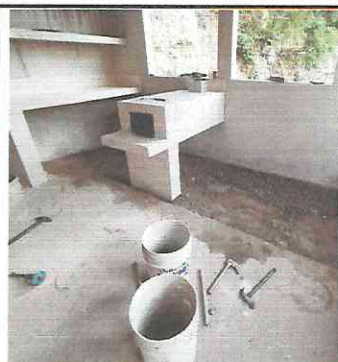
FOTO 5: PREPARACIÓN Y FUNDICIÓN DE PISO DE CONCRETO Y CONSTRUCCIÓN DE ESTUFA RURAL CON PLANCHAY CHIMENEA
